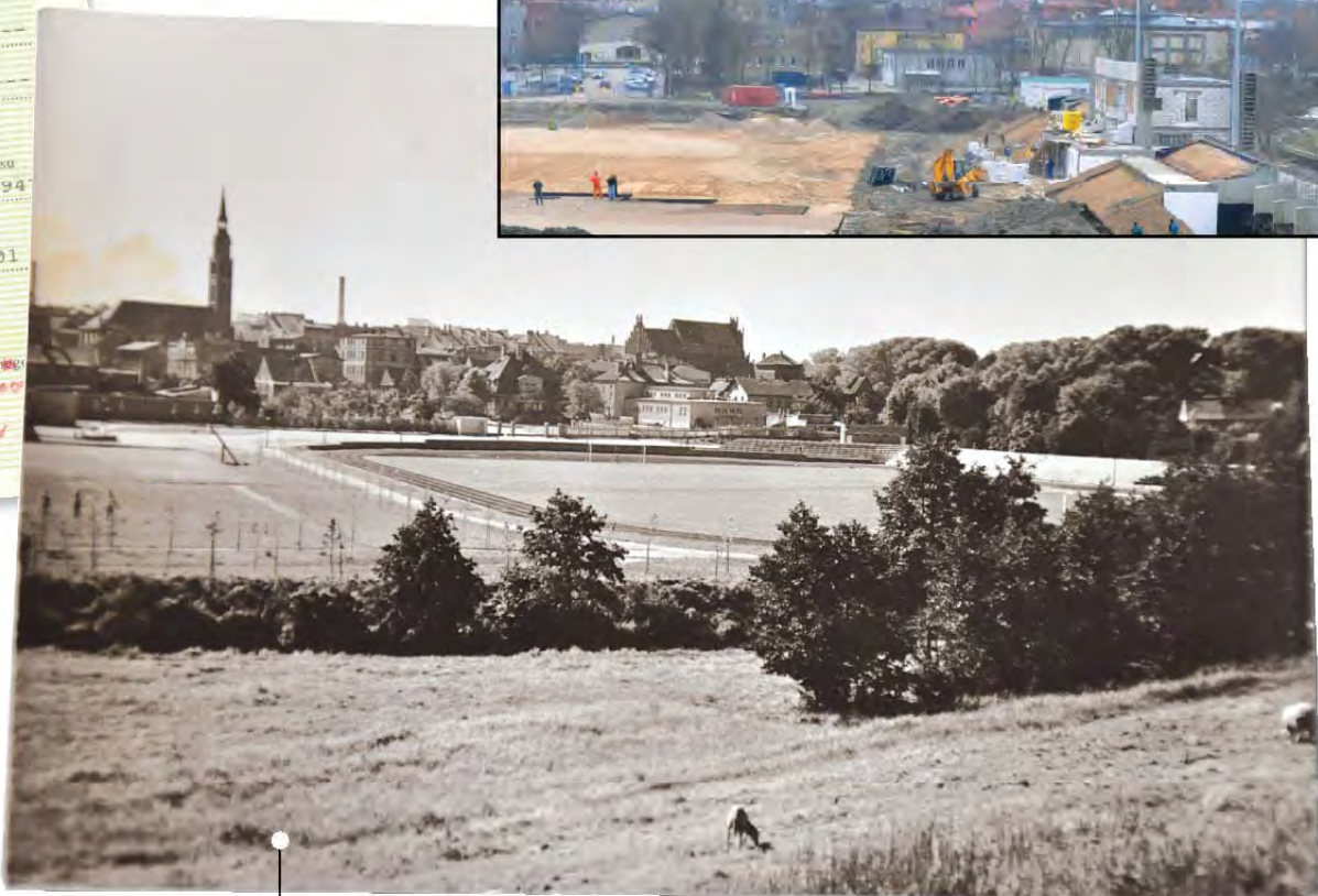
Stadion 1000-lecia na pocztówce z lat sześćdziesiątych (na dole) i ten sam stadion wiosną roku 2011, kiedy trwały na nim prace budowlane. Nosił już wtedy imię Kazimierza Deyny. Z lewej wieża kościoła św. Katarzyny
